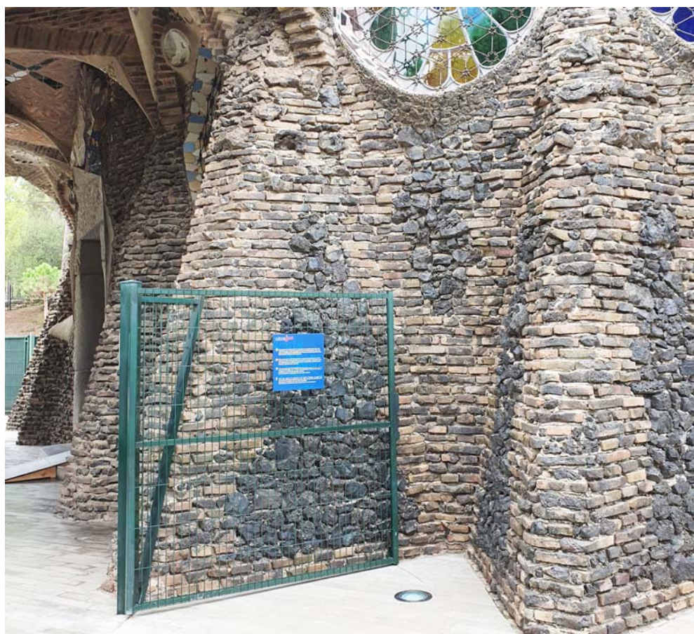
B2 04 – La presència de tanques d'obra de disseny poc acurat, pràcticament a tocar de la construcció de la Cripta, ofereixen una imatge poc harmònica amb els seus elevats valors patrimonials i artístics
